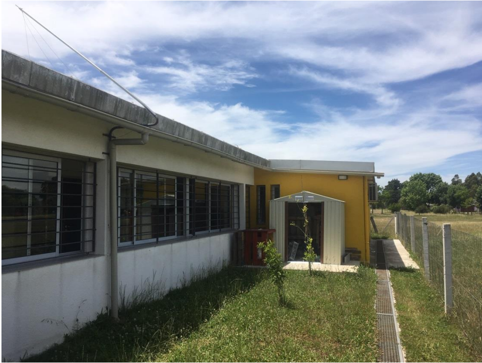
Patio, el canalón lo agregó la OSC, no afecta la red de desagües
